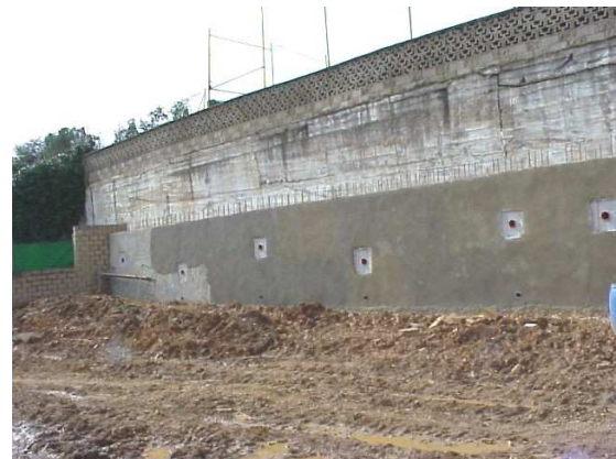
Refuerzo de muro de contención
