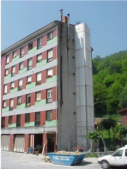
Hueco de ascensor
